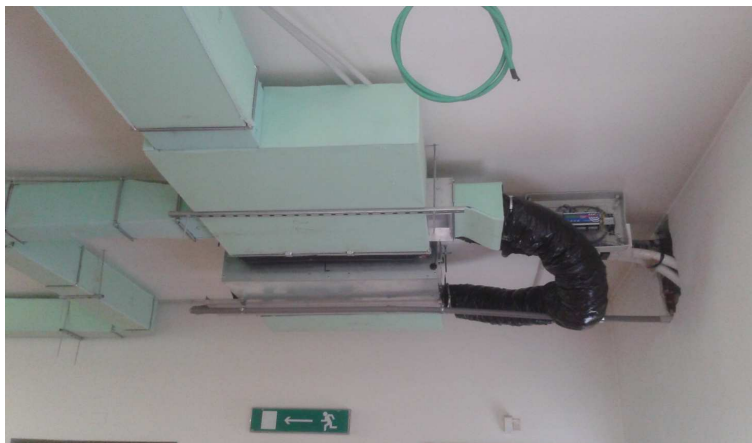
Installazione di un ventilconvettore canalizzato e della relativa rete di distribuzione
